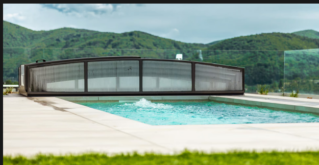
Bazén so skimmerovým odtokom a 3D fóliou v imitácii kameňa. S protiprúdom, ohrevom a bazénovým prekrytím Alukov VIVA.
